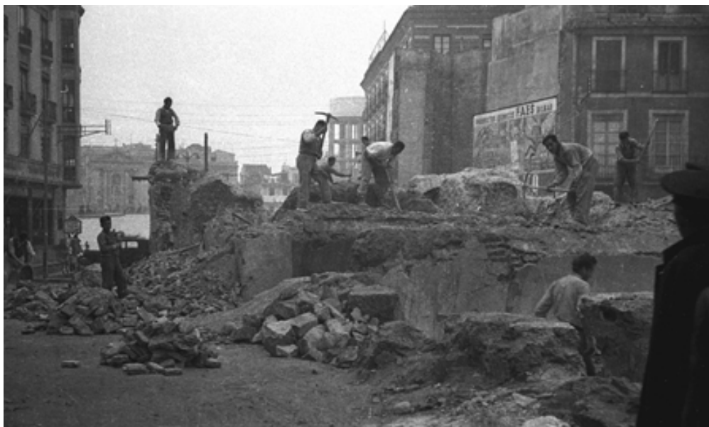
Imagen 4. Derribo de los Baños Árabes, 1953. Fuente: Archivo Municipal de Murcia, Catálogo J. López.
